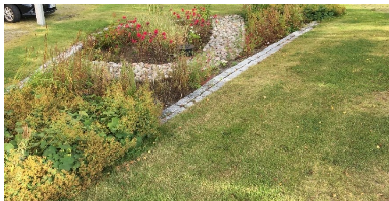
Esimerkkikuva hulevesien viivytyspainanteesta. Kuva Tampereen kaupunki 2021.
